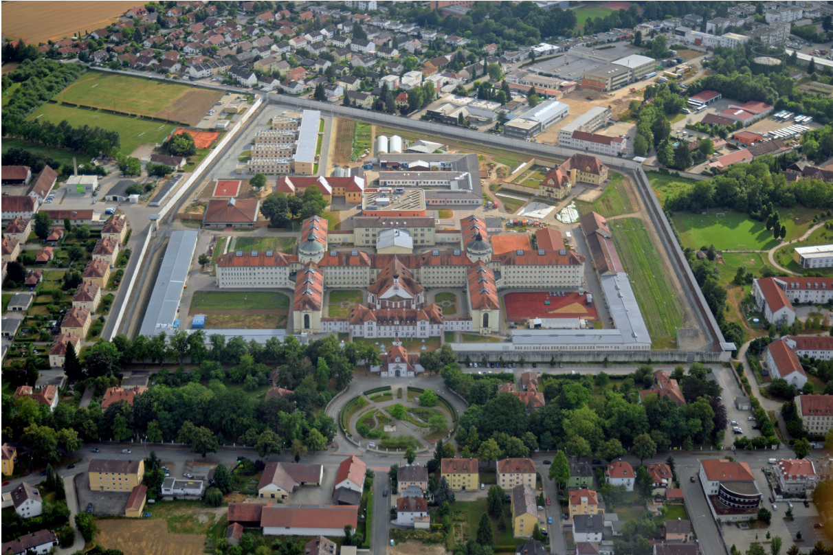
(Luftbildaufnahme der Justizvollzugsanstalt Straubing mit Einrichtung für Sicherungsverwahrung)
