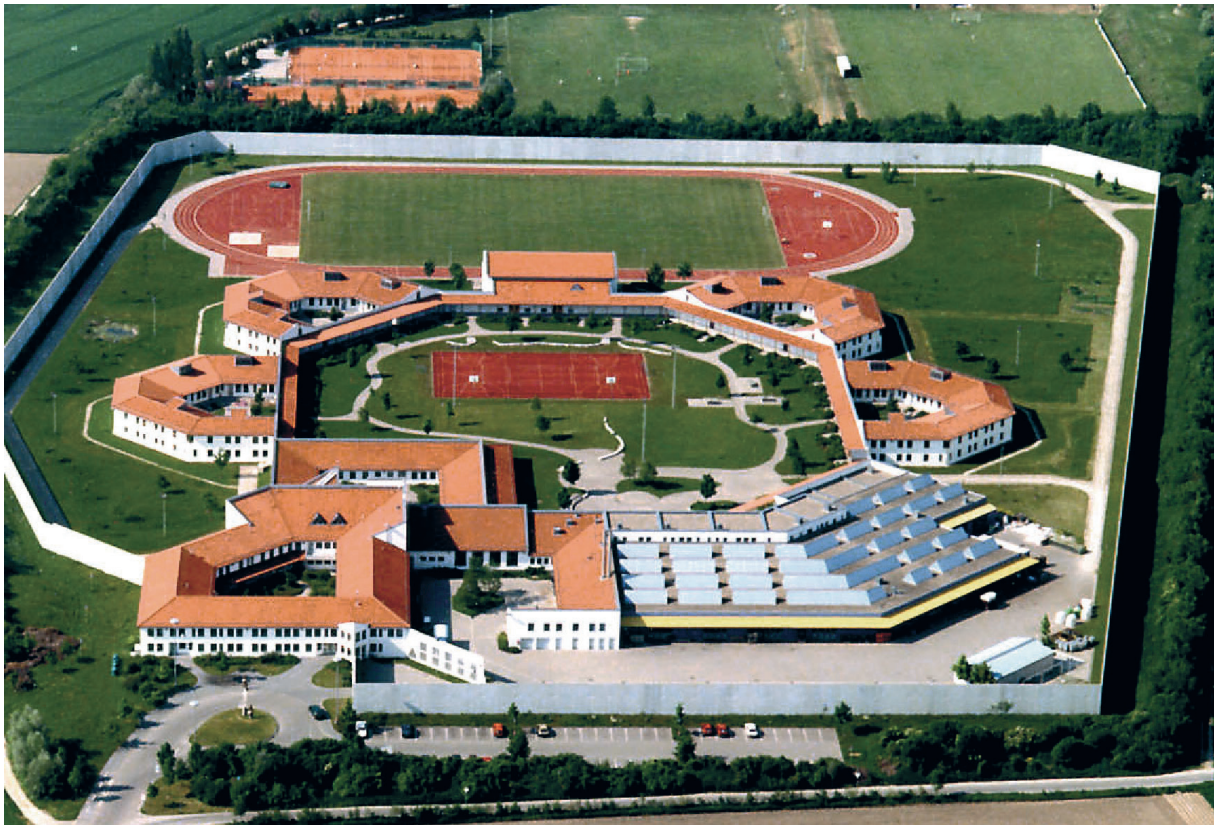
(Luftbildaufnahme der Justizvollzugsanstalt Neuburg-Herrenwörth)
