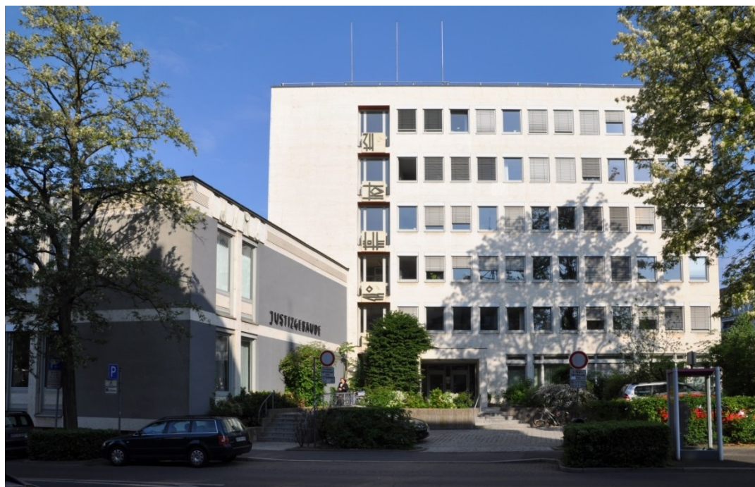
Bild: Justizgebäude Aschaffenburg – vor der Sanierung (Foto: Staatliches Bauamt Aschaffenburg)
