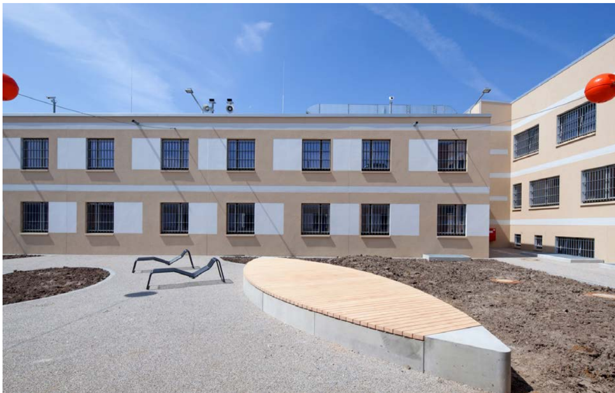
(Einrichtung für Sicherungsverwahrung der Justizvollzugsanstalt Straubing)
