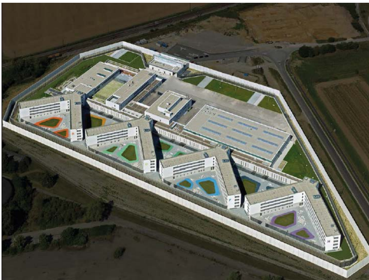
(Luftbildaufnahme der Justizvollzugsanstalt Augsburg-Gablingen) Hajo Dietz, Luftbildfotografie
