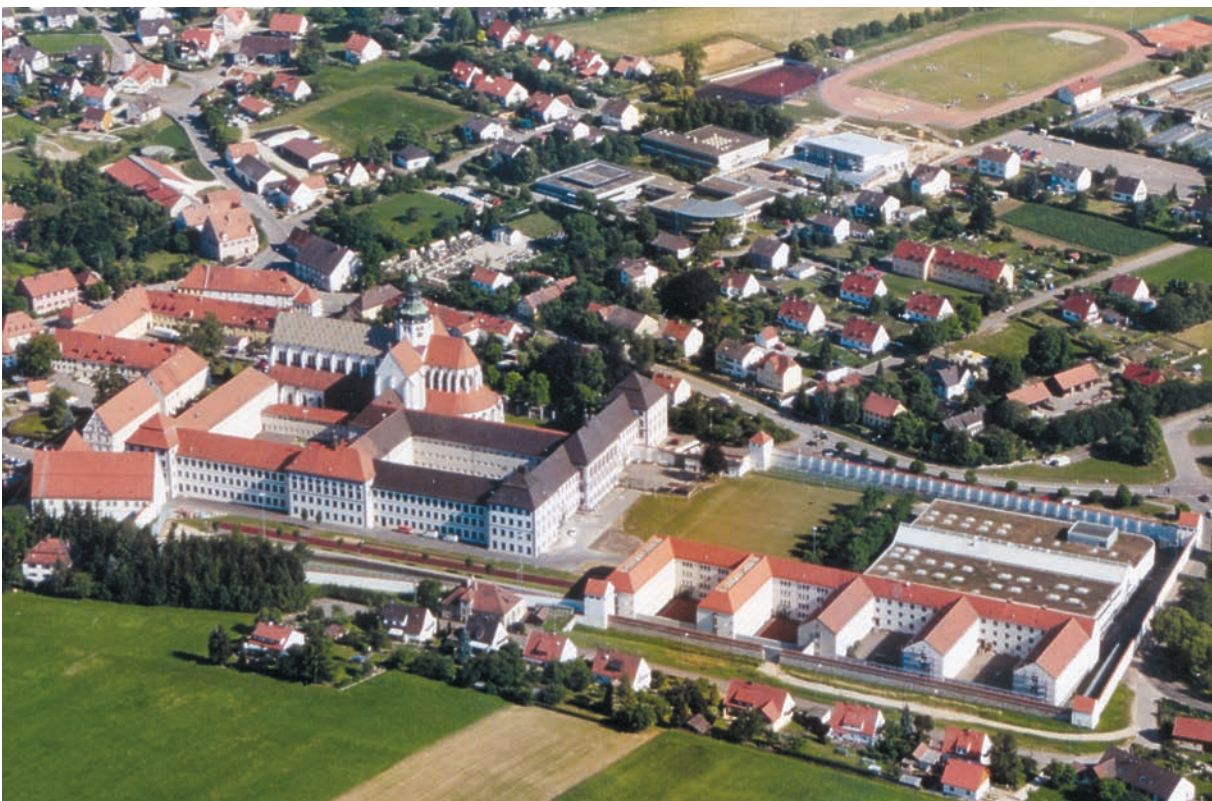
(Luftbildaufnahme Justizvollzugsanstalt Kaisheim)
