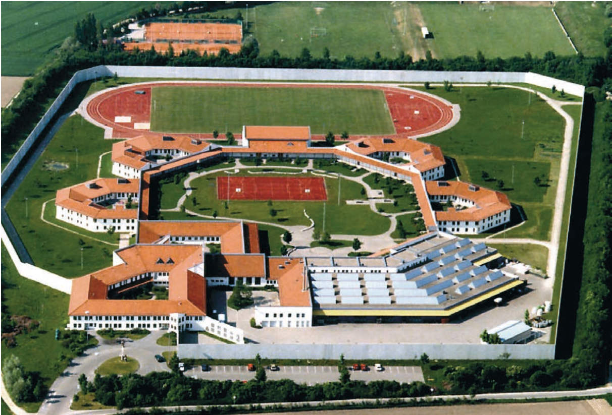
(Luftbildaufnahme der Justizvollzugsanstalt Neuburg-Herrenwörth)
